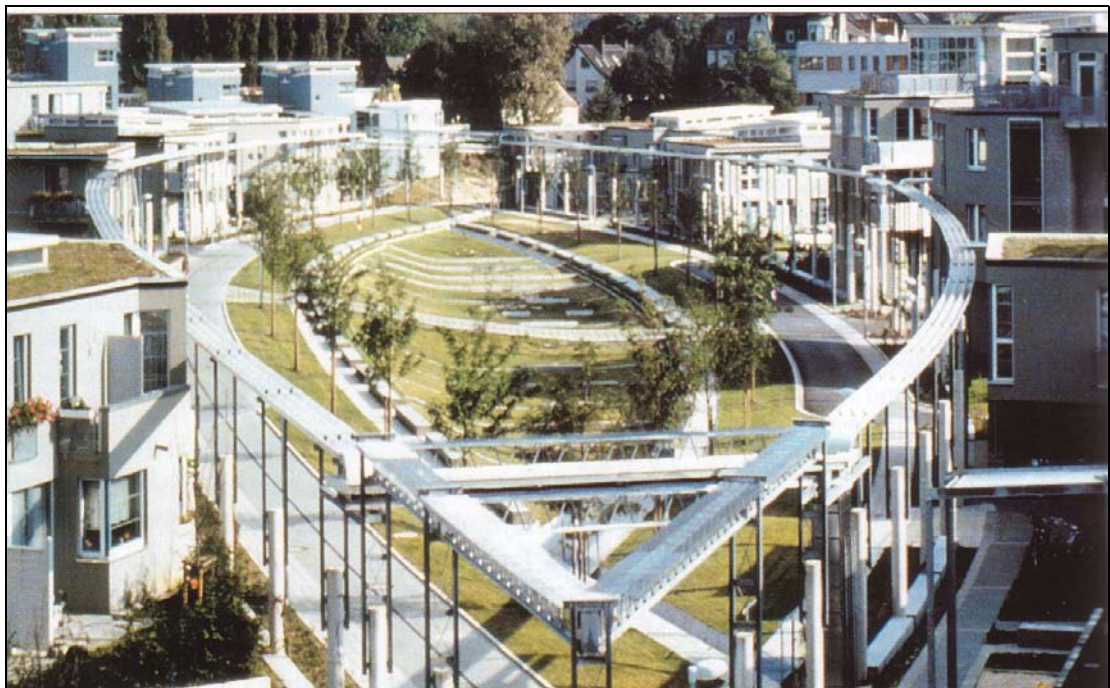
Fig. 33 A água da superfície é conduzida para esta área central, de aproximadamente 1.150m 2 . Esta tem 30cm de espessura de solo e abaixo deste uma camada de granulado vulcânico ( Lavagranulat ) com capacidade de armazenamento de 300m 3 . O solo abaixo é pouco permeável e o lençol freático está ainda a 2,2m de profundidade. Para casos de chuvas intensas existe uma saída de emergência do excesso de água para a rede.
