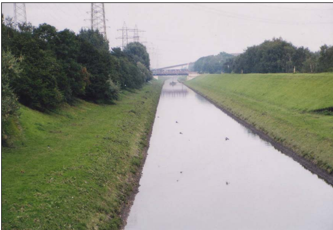
Fig. 2 Rio Emscher entre taludes de proteção contra enchentes. Foto ago.2002
