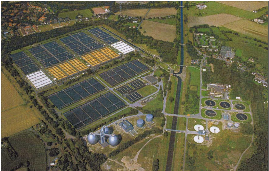
Fig. 22 Vista aérea da estação de tratamento de esgotos na foz do Emscher, na cidade de Dinslacken.
