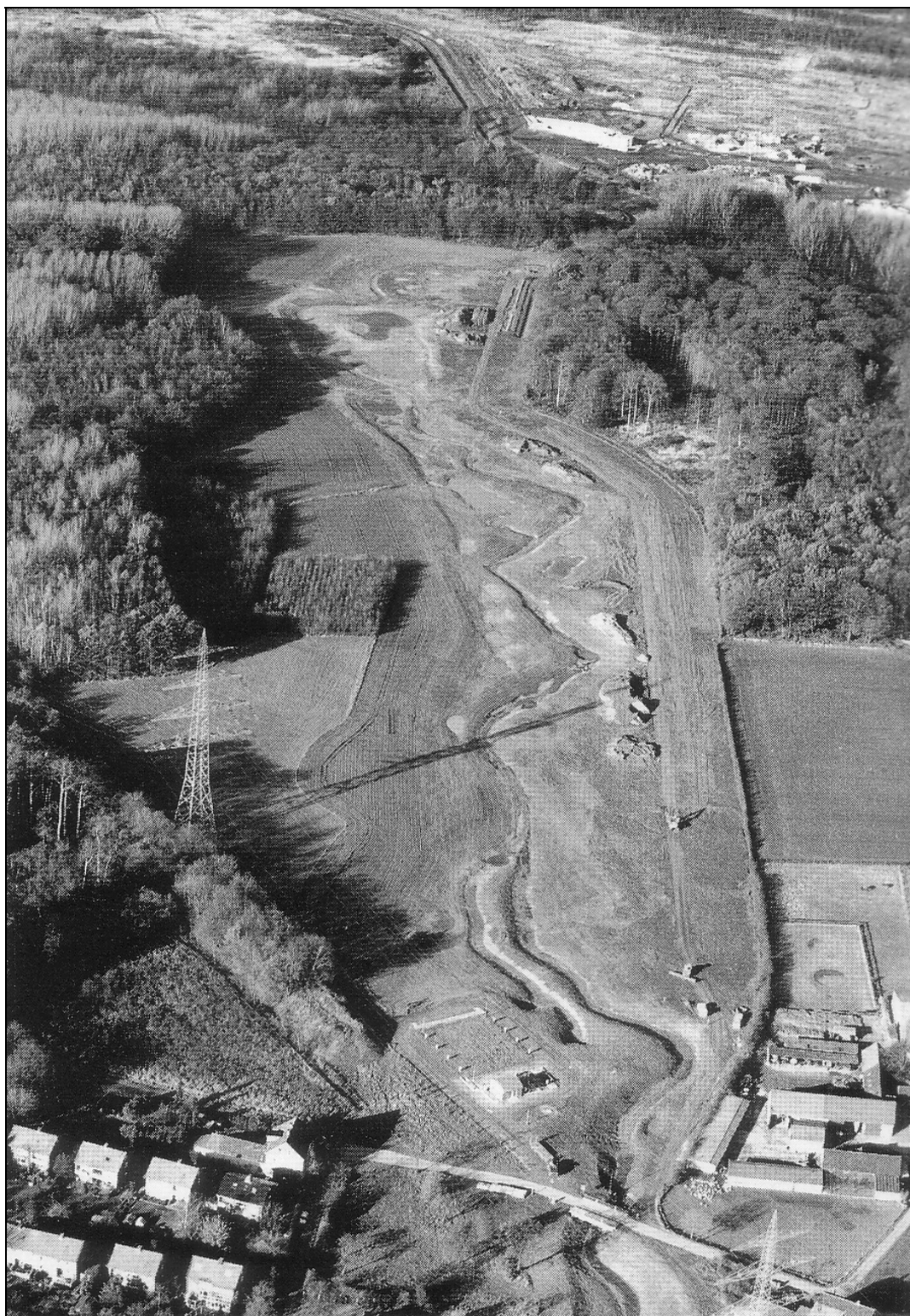
Fig. 37 Remodelação do traçado do córrego Deininghauserbach no seu curso médio. Do lado direito, entre o cercamento e o traçado dos meandros encontra-se o curso anterior, em linha reta. Fonte: Internationale Bauausstellung. Foto 1998
